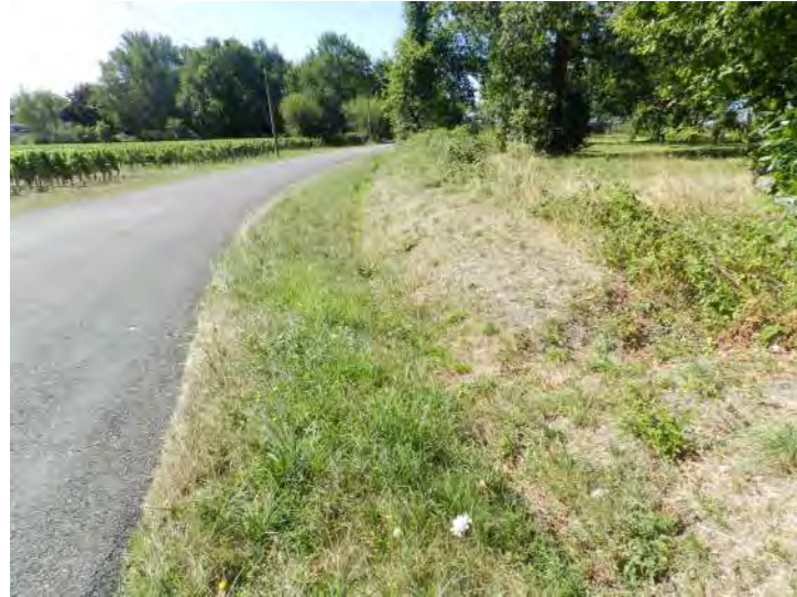
Photo 1 - Fossé en bord de route pour aménagement des eaux pluviales du plateau
